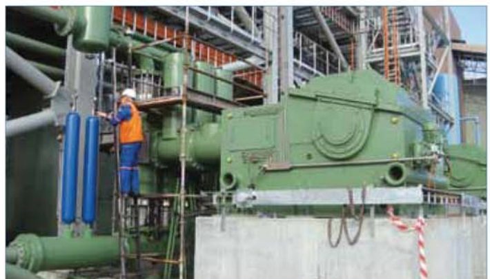
Abb. 8: Doppel-Schlauchmembranpumpen in Drillings-Ausführung im Einsatz
